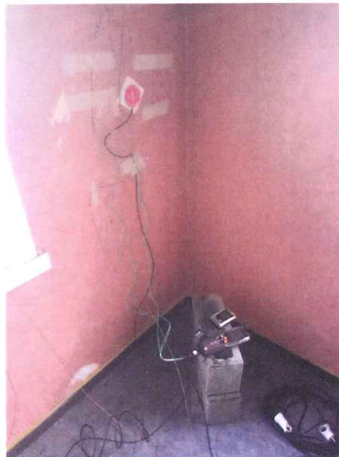
Figuur 11: Thermische fluxsonde voor de karakterisering van de U-waarde van de gevel
