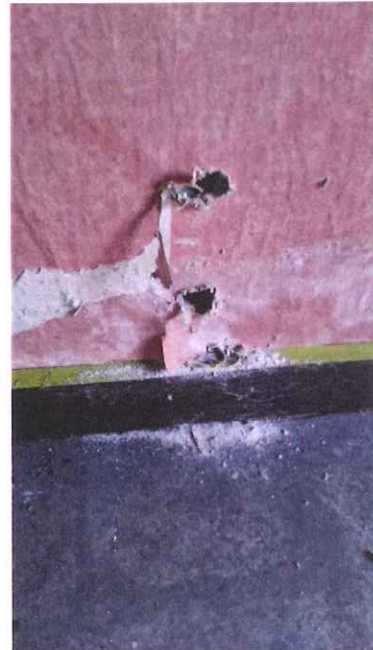
Figuur 12: Metingen met carbidefles aan de achtergevel op het gelijkvloers (Carb2)
