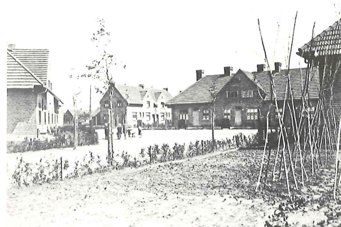
Tuinwijk te Zaventem (J. De Ligne - 1921) (links) - tuinwijk te Mol-Toemaathoek (H. Derée - 1922) (rechts).
