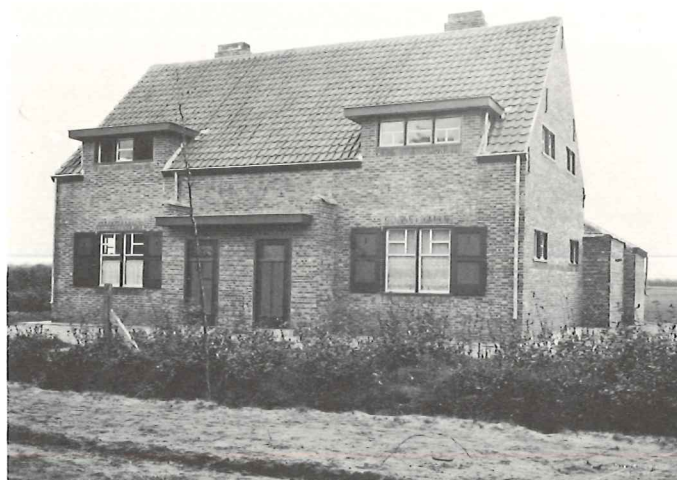
Klein Rusland te Zelzate: woningtype in baksteen (boven) en asbeton (midden) - Symbolische modernistische esthetiek (onder).
